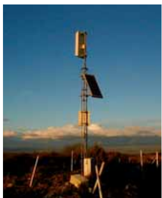
Station sismologique à Lubilhac
